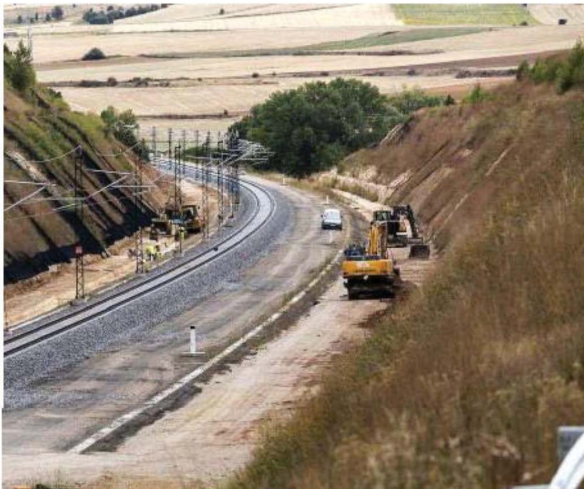
Obras del AVE a la altura de la localidad burgalesa de Estépar. / ALBERTO RODRIGO
